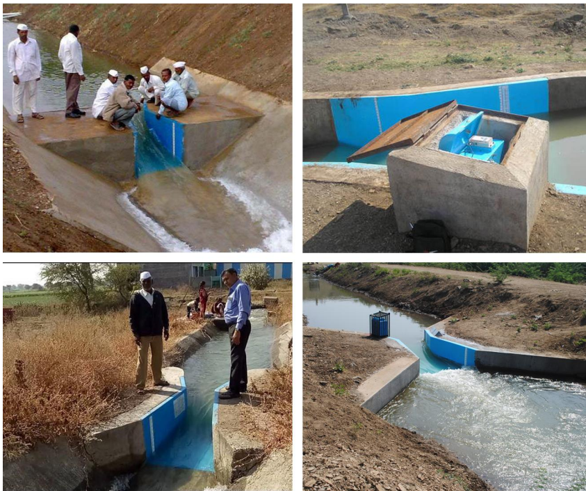
Рисунок 4. Лотки Паршалла на оросительных каналах
