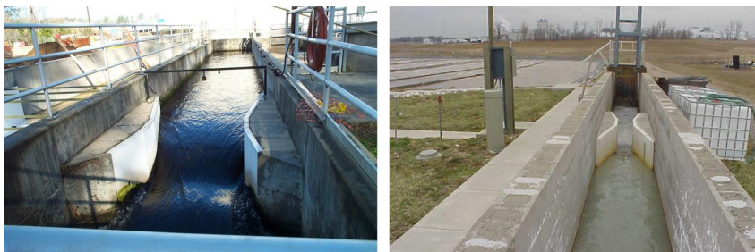
Рисунок 5. Лотки Паршалла в бетонных прямоугольных каналах
